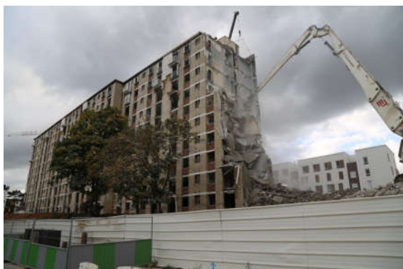
Démolition dans les quartiers de La Coudraie à Poissy
